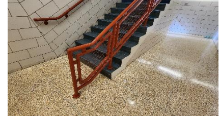
NON – ADA COMPLIANT GUARDRAILS
